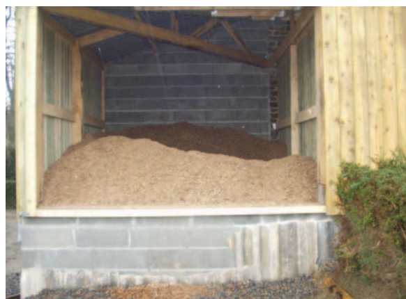
Silo de stockage des plaquettes
